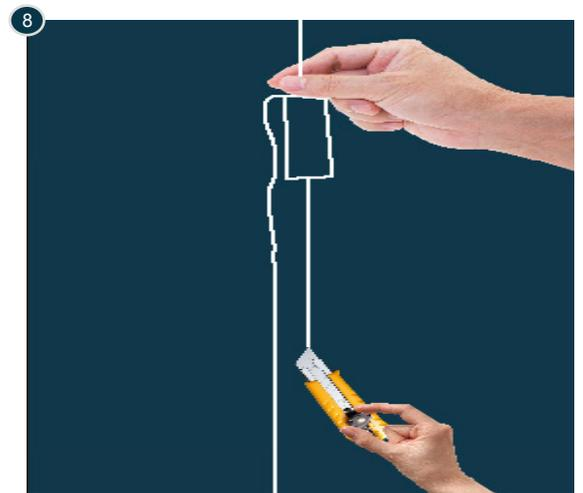
Con un cutter y ayudandote de una regla o fleje, haga un doble corte vertical de techo a suelo.
